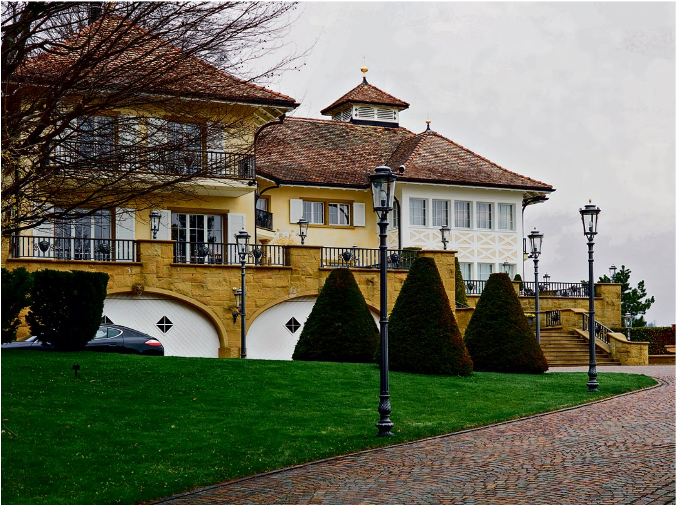
Illegales Dachgeschoss, illegales Untergeschoss, illegale Türme, illegaler Lift: Villa in Goldingen SG
